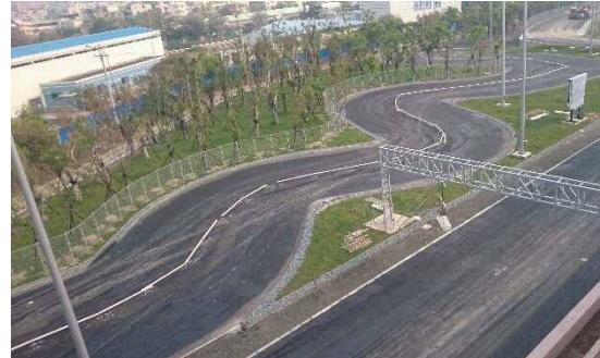
鈴鹿サーキットの約1/10のレンタルカートコース 建設中の様子 (3月30日撮影)
