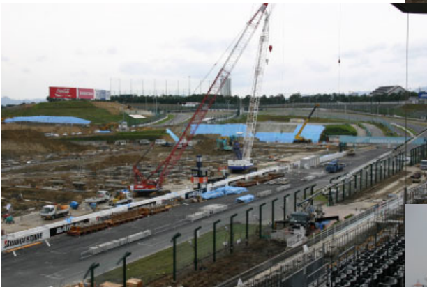
ピットビル、パドック工事風景
