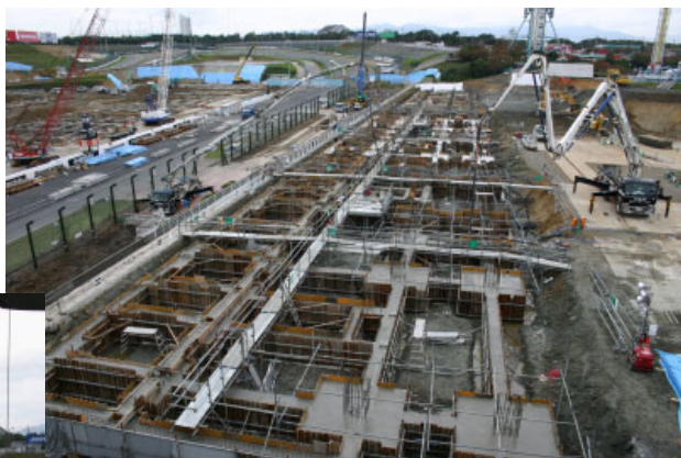
グランドスタンド工事風景
