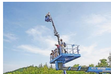
高所作業車リフトアップ体験
